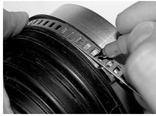
Schritt 2 Ermittlung der Klemmenlänge.
